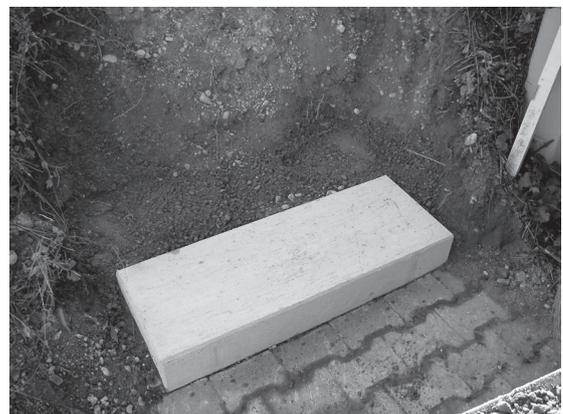
Abb. 20 Einbau Beton-Blockstufen; Fa. Cavigelli Gartenbau
