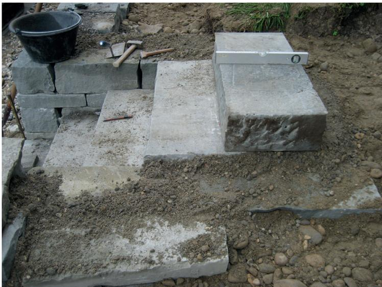
Abb. 22 Treppe aus Sandstein-Blockstufen; Fa. Gartenbau K. Köchli, Bild: B. Schäppi
