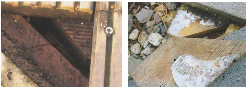
Abb. 8-9 Nasse Unterkonstruktion-Zu kurze Endstücke
