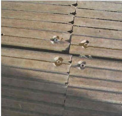
Abb. 12 Verspringende Schrauben und sehr weit aufgerissene Senklöcher
