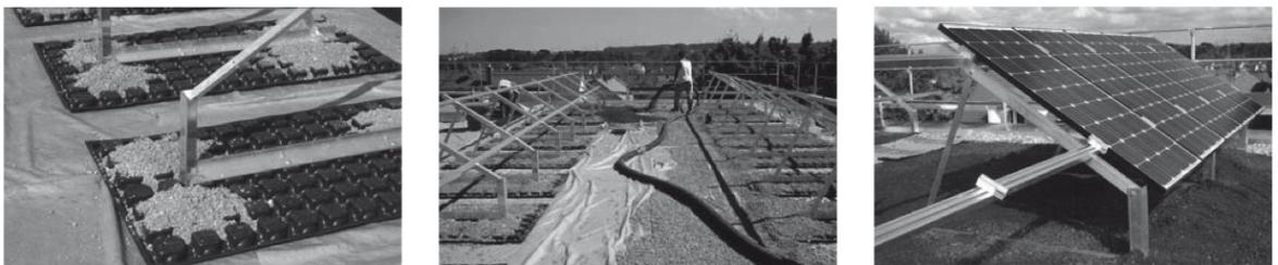
Abb. 8 Solargrundrahmen mit kombiniertem Vegetationsaufbau (Quelle: [www.zinco.ch](http://www.zinco.ch))
