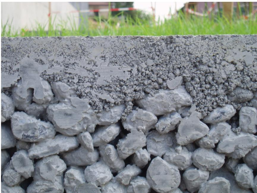
Abb. 11 Ausschnitt Drainbetonmauer
