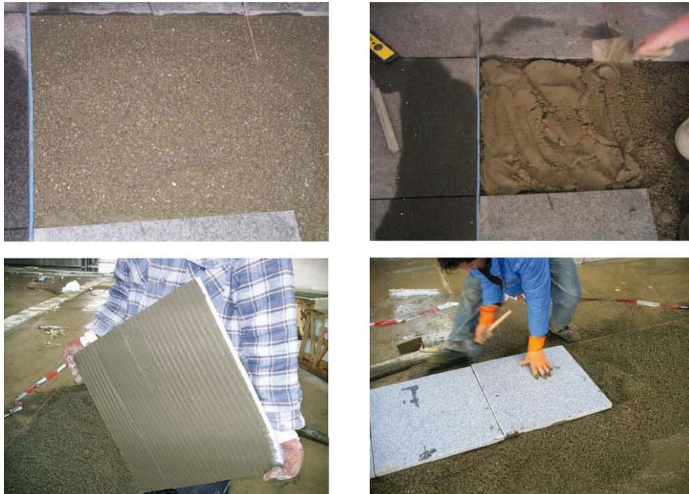
Abb. 16-19 Beispiel Plattenverlegung mit Monokormörtel
